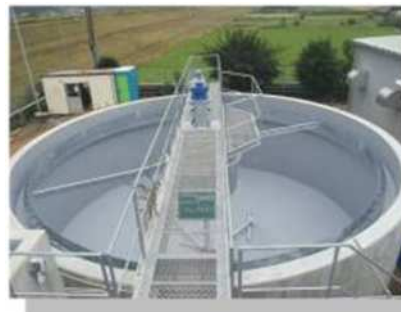
JA汚水処理施設防食・防水処理
