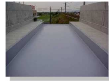
JR鉄道コンクリート橋 床版防水
