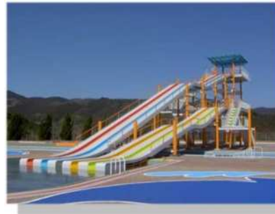
運動公園スライダー全面塗装
